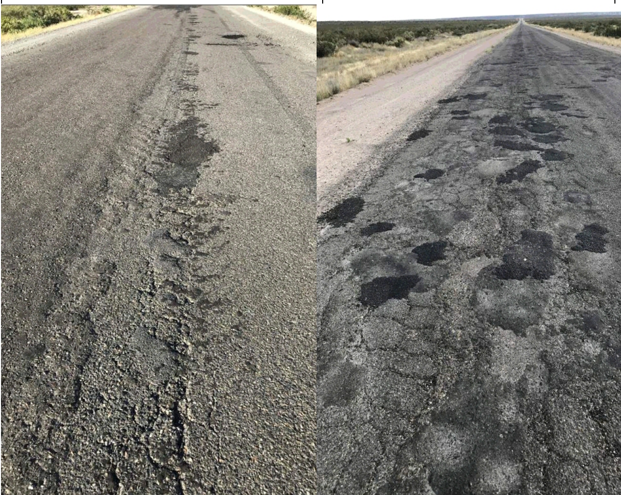
Foto 40, 41, 42 y 43. Estado actual del área de intervención
