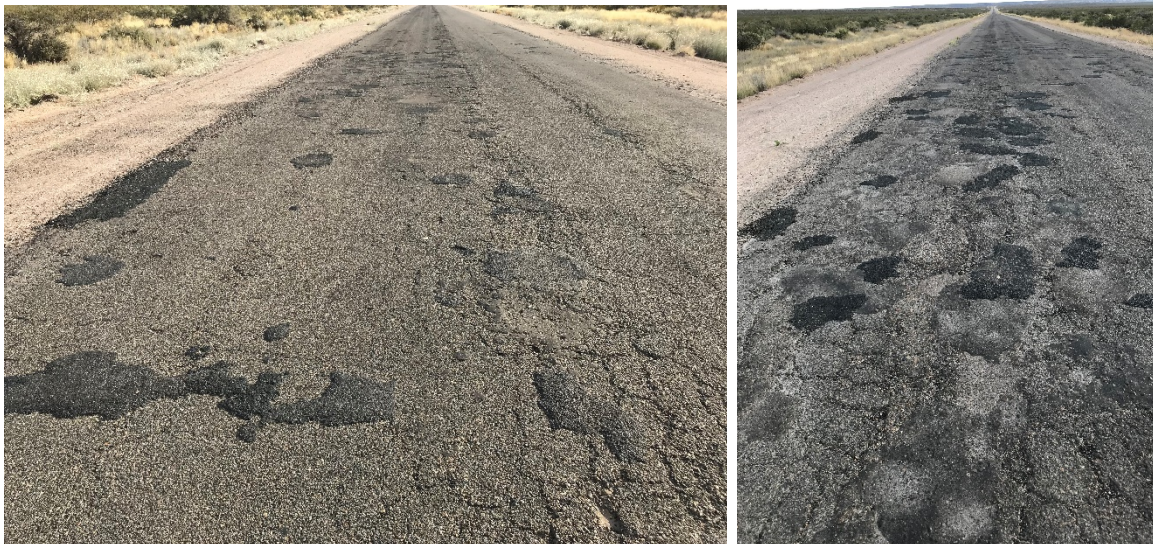
Foto 38 y Foto 39. Estado actual de la RP N° 6
