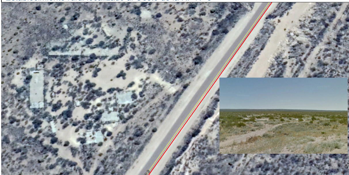
Establecimiento rural localizado al Oeste de la RP N° 6
