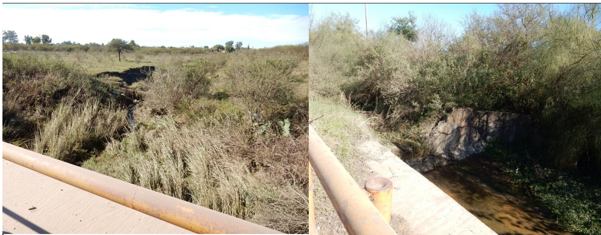
Foto 1. Intersección del proyecto con el arroyo Cda. María Gomez en la progresiva 3+000
