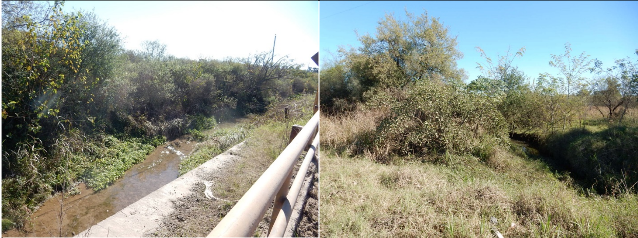
Foto 10. Intersección del proyecto con el arroyo Cda. María Gomez en la progresiva 3+000
