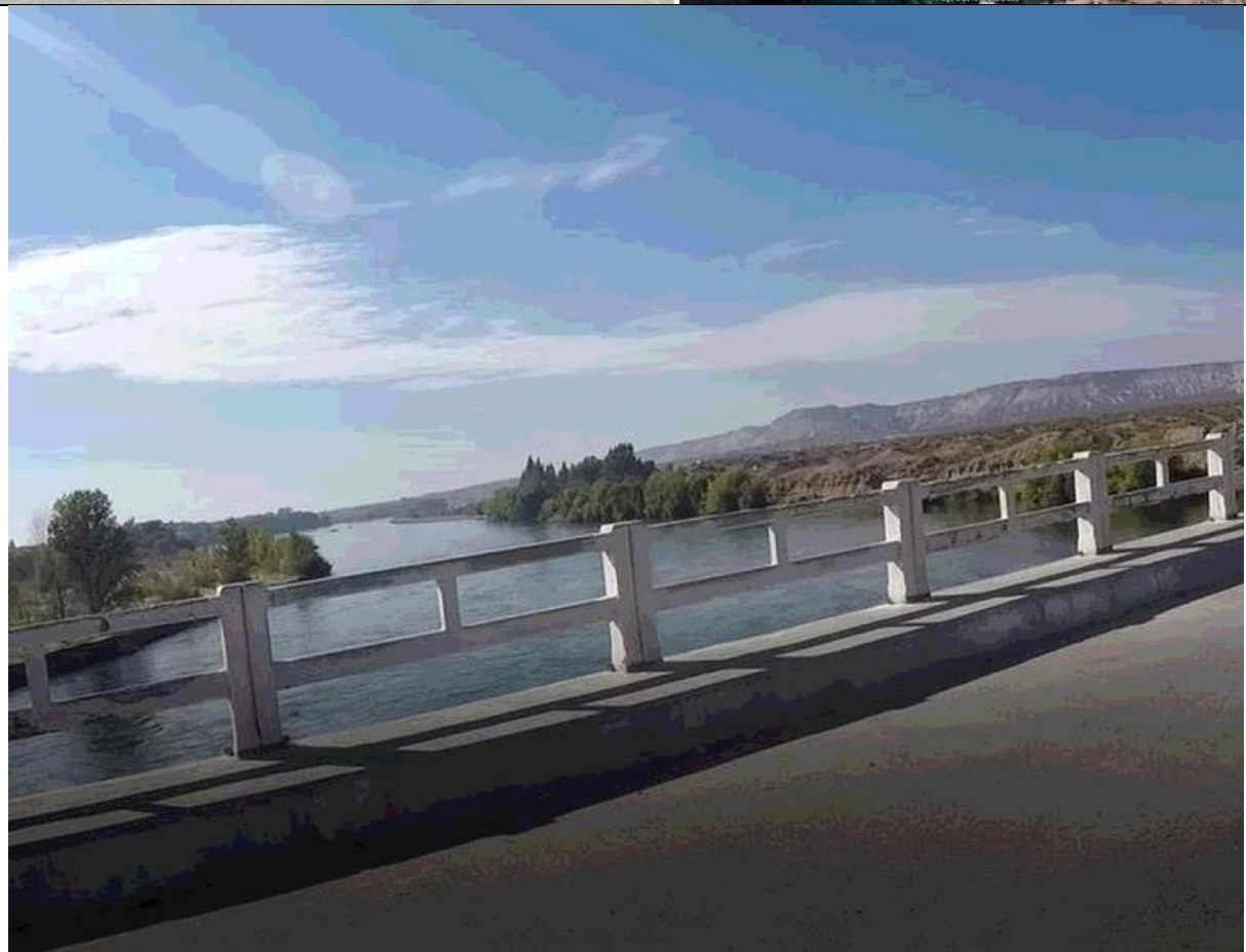
Foto 1 y 2. Puente de la RP N° 6 sobre el río Negro
