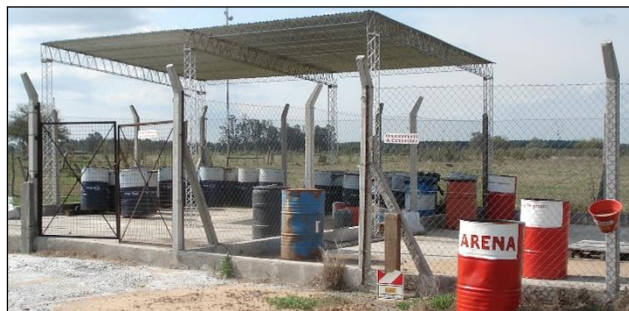
Ejemplo de recinto (con aislamiento en el solado y techado y muro de contención) para residuos peligrosos
