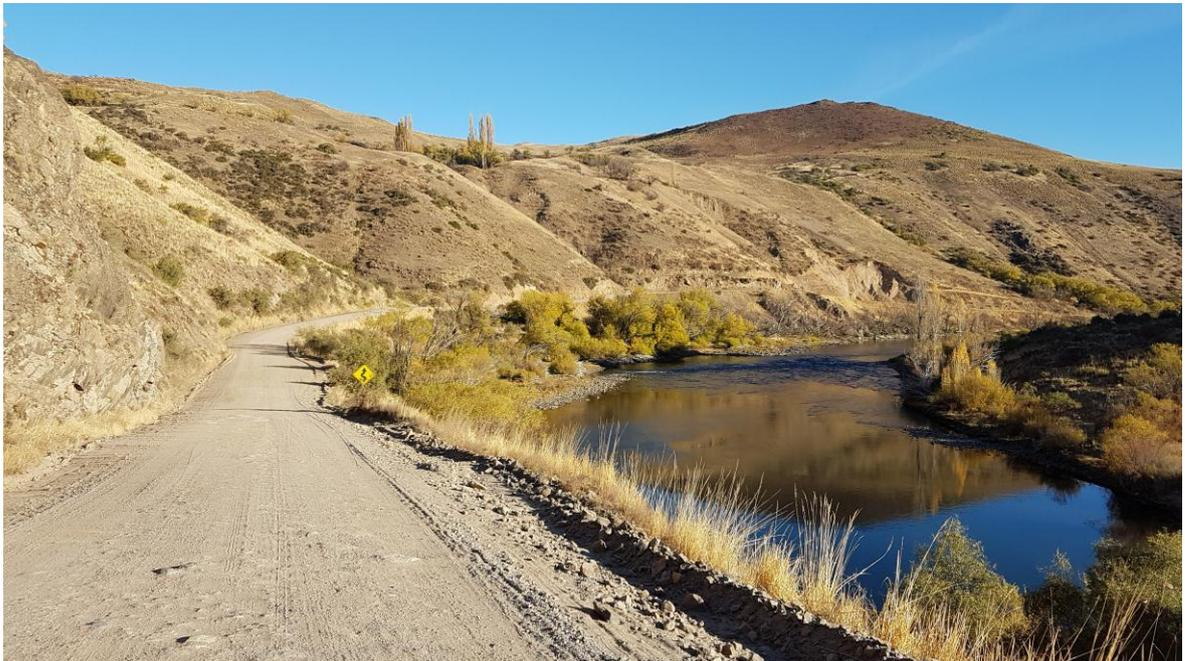
Foto 5- Km 1 Ruta muy próxima al río. Desmante en lateral izquierdo (roca y suelo en talud a estabilizar)
