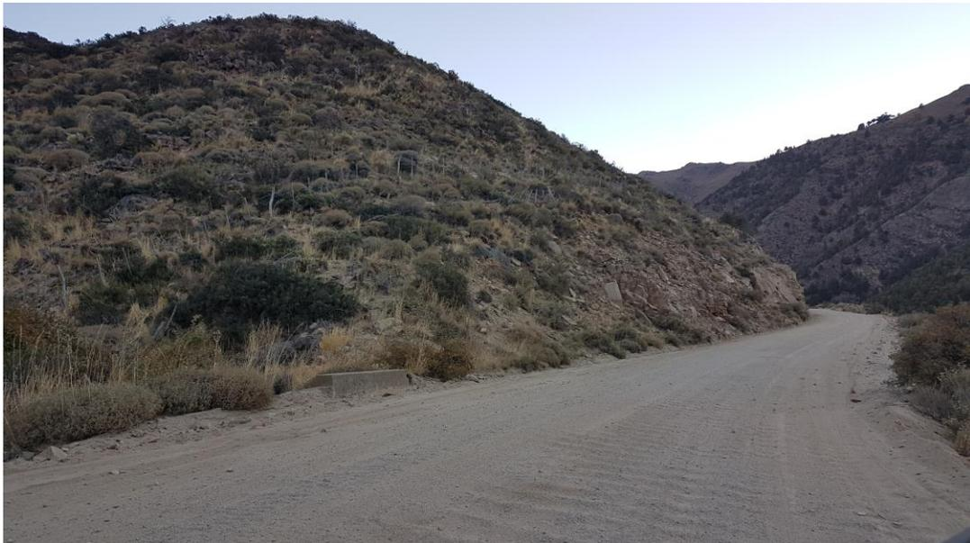
Foto 15- Km 20- Calzada con serrucho. Desmante en contratalud
