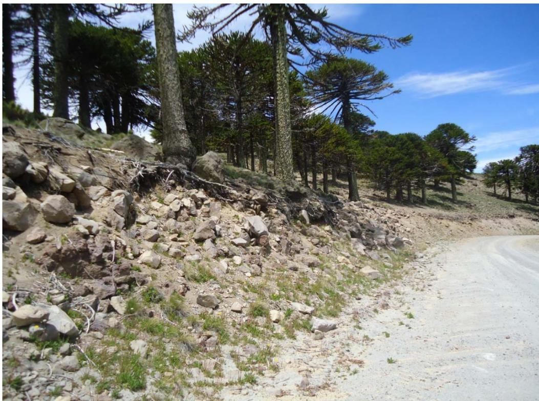
Deslizamientos rotacionales en el contratalud con fenómenos de reptación de ladera.
