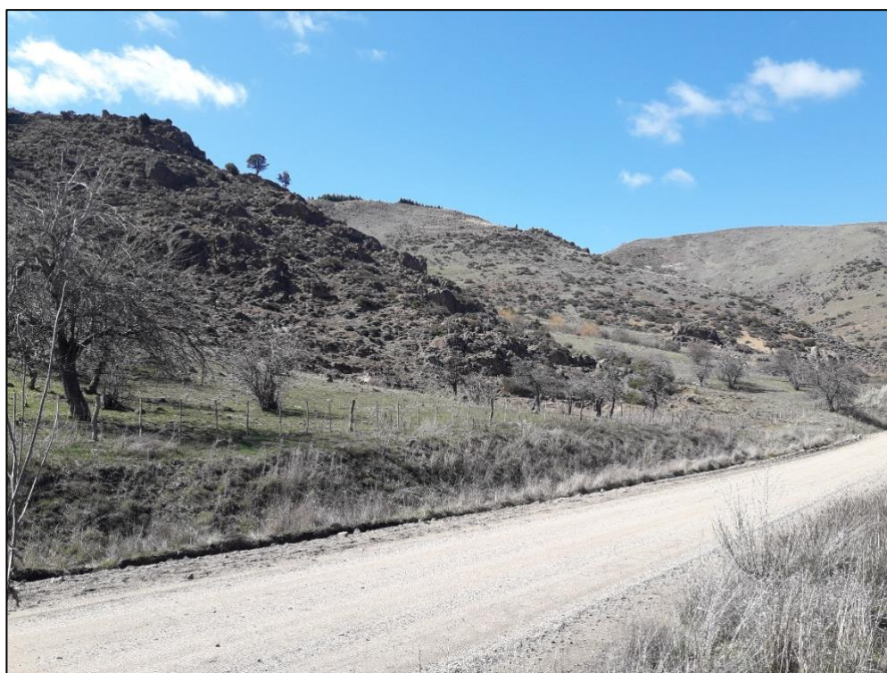
Vista de Ruta P. 23 y campo de manzanos sobre margen Izquierda sentido Rahue-Pilo Lil. Progresiva 10200-10300. (Septiembre 2021)
