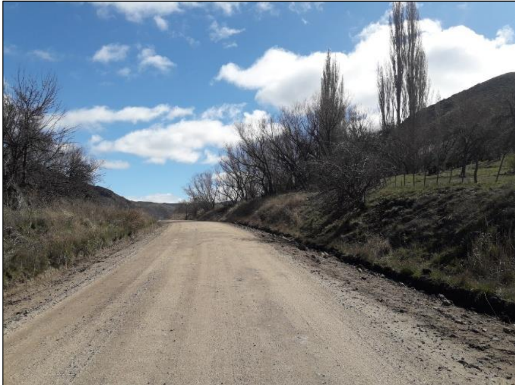
Vista al Norte desde progresiva 10135. Septiembre 2021.
