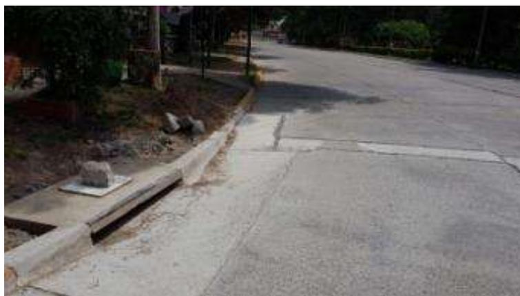
Figura 41: Sumidero con boca de tormenta en la pared vertical.
