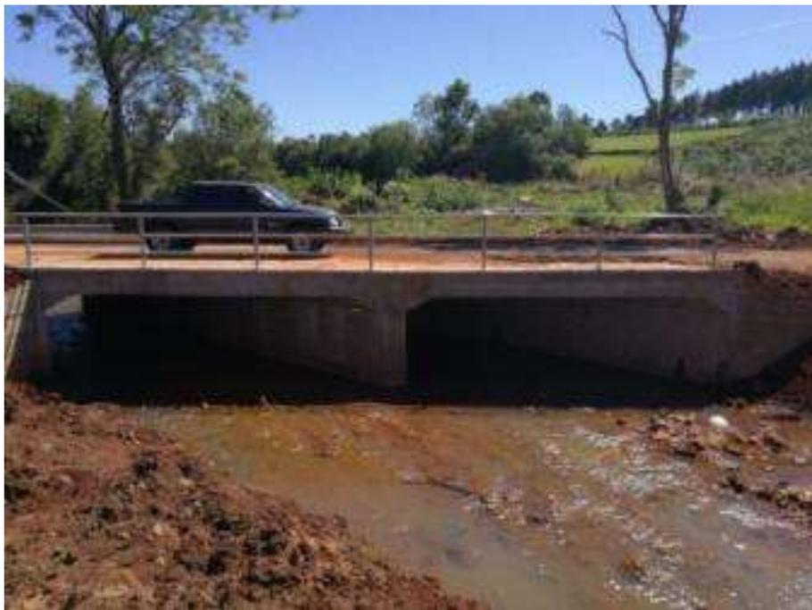
Figura 44: Alcantarilla tipo cajón.
